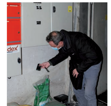
Diagnostic de vulnérabilité d'une école - Janvier 2021
