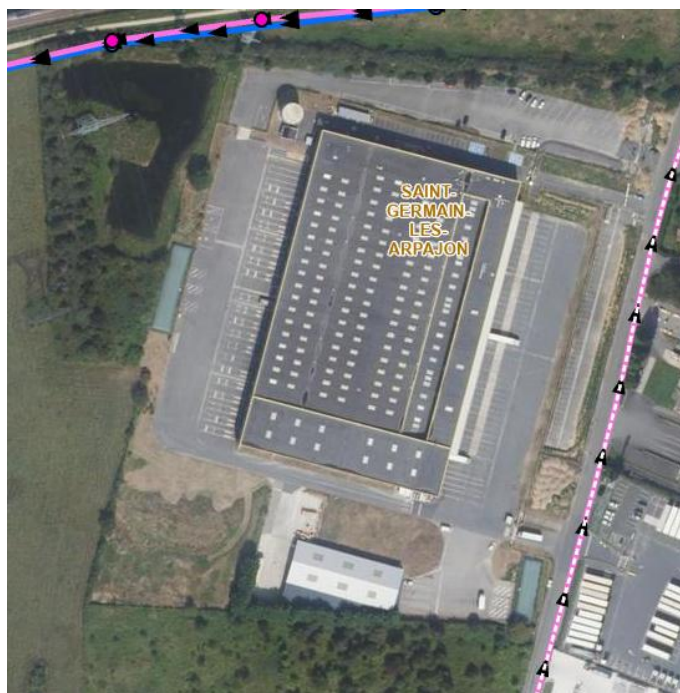
Bassin de rétention (ex-Lidl)
