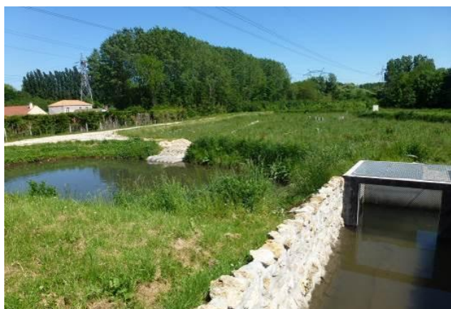
Bassin de dépollution naturelle
