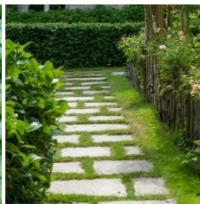
Pavés à joints enherbés
